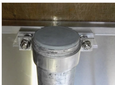
3. Znak prislonimo k drogu, namestimo ukrivljen alu profil ter podložko in matico.
