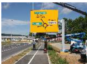
Postavljanje vertikalne prometne signalizacije
